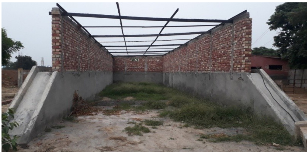
Fig. 4: Silage pit cum storehouse
